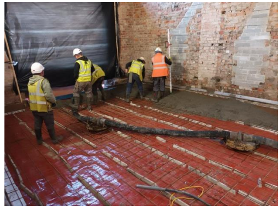
Concrete Pour Block B
