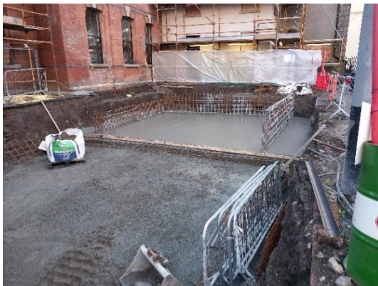
Block C Southern Planter attenuation Area Slab pour No.1
