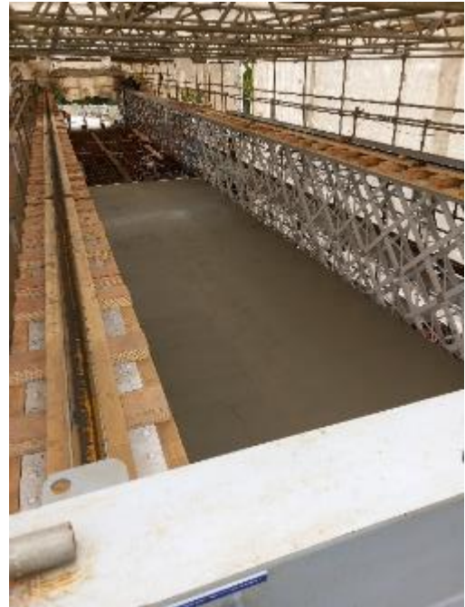
Bridge Deck Slab Pour 1
