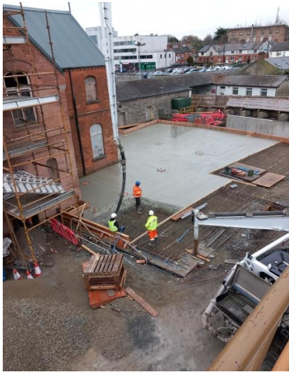
Block N New Link Building Slab pour
