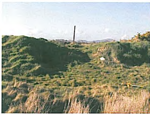
Photo 29 – chainage 1093 Steep toe back face
