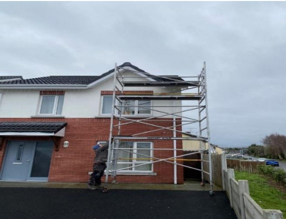
Storm Éowyn Repairs
