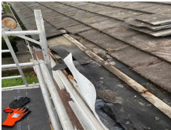
Storm Éowyn Repairs
