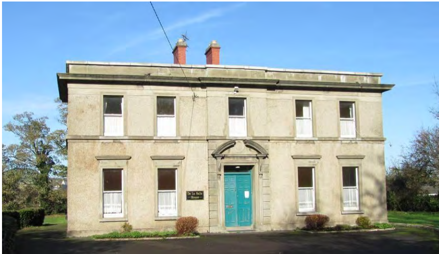
Fig. 87: De La Salle House
